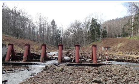
河川の蛇行の仕組みを活かした上下流分離型の流木補足工（治山工事）
