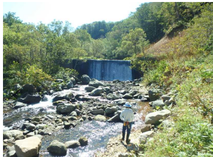
過去に設置した治山ダム
