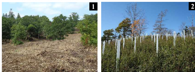
1: 大型機械による地がき後の様子 (笹地8) 2: 植栽・保護管被覆後の様子 (笹地9)
