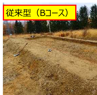
写真1 試験用林道構築の様子
