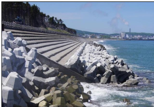
写真2: 補強対策工完了区間状況
