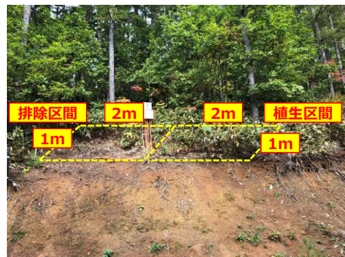
写真2 現地計測を行った切土のり面
