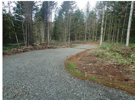
写真-1 作設した林業専用道
