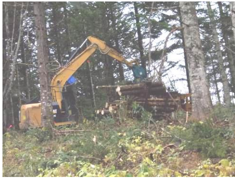
写真―2 フォワーダがストリップロード (伐採列内) に入り、グラブプルにより積み込み作業を行っている状況
