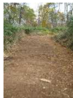
写真4 表土攪拌切削
