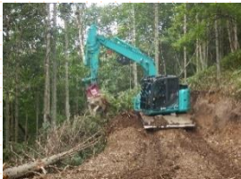
フェラバンチャー付きバケットに よる森林作業道の作設
