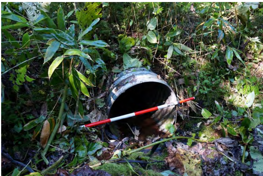
A-23の既設コルゲートパイプ 呑口(φ0.6m)
