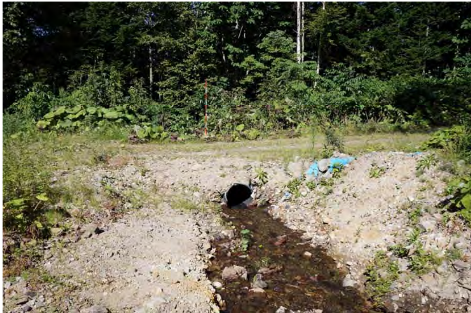
A-18～A-19 の沢上流から CL 方向 呑口 既設ポリ波状管 (φ0.6m)
