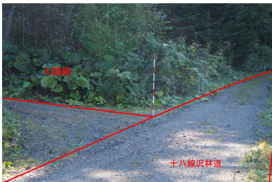
十八線沢林道からの分岐点（起点）
