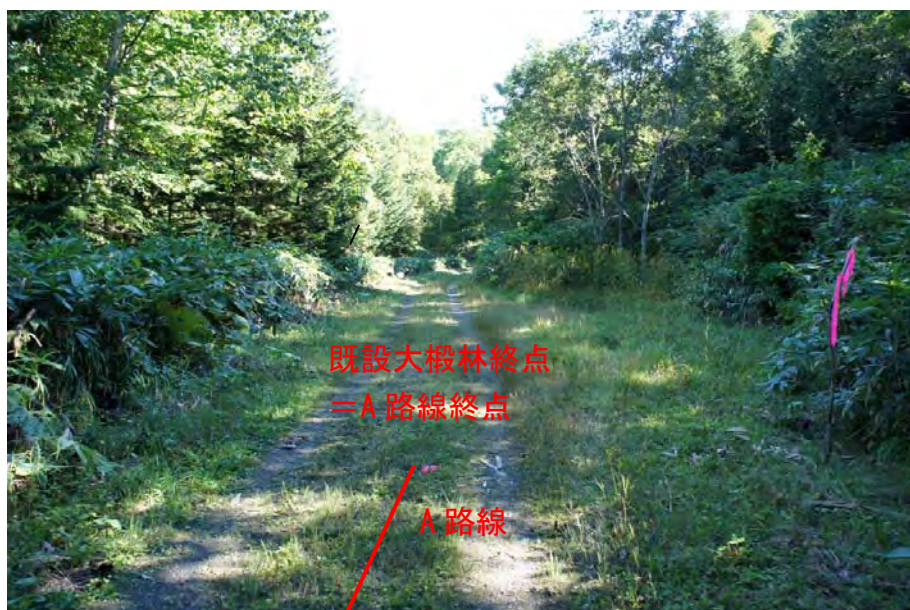
終点 A-83 から既設大榎林道起点方向
