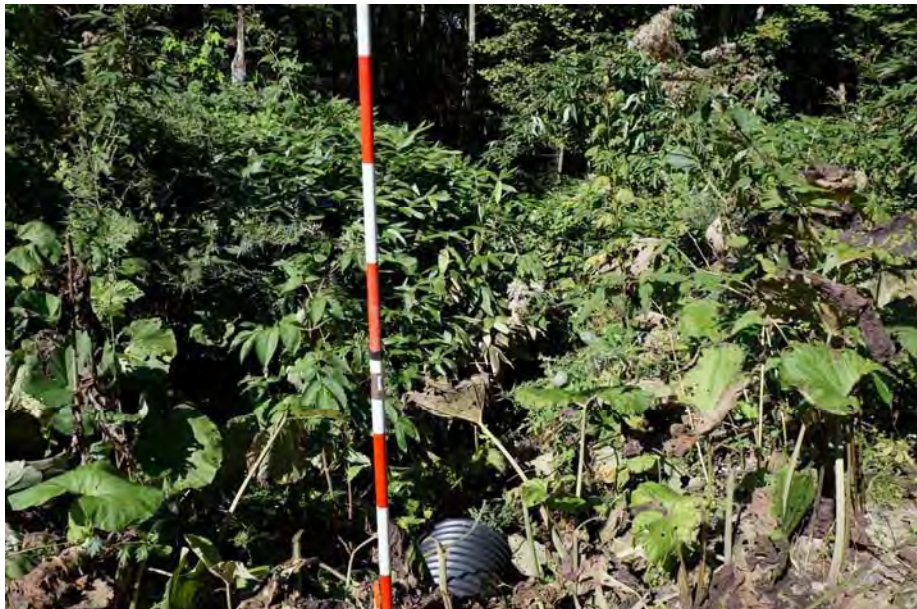
A-18～A-19 の沢下流方向 吐口 既設ポリ波状管 (φ0.6m)
