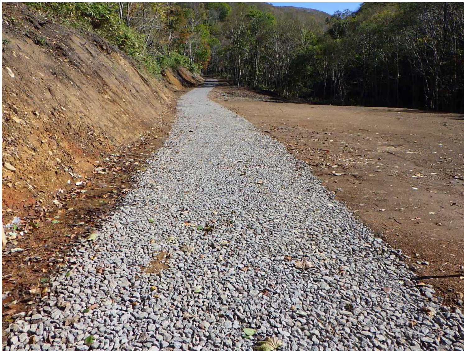
後志森林管理署 稀府林道（林業専用道）新設工事
