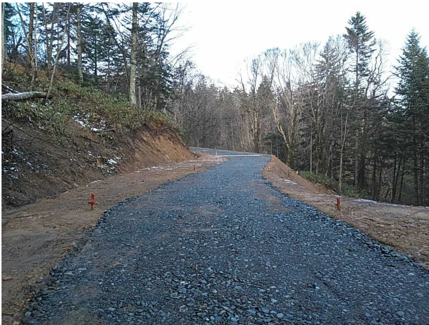
空知森林管理署 扇風機の沢作業道（林業専用道（規格相当））新設工事
