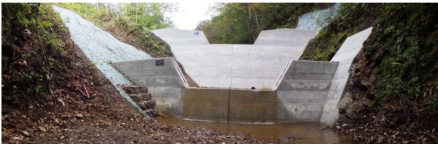
コンクリート床固工
