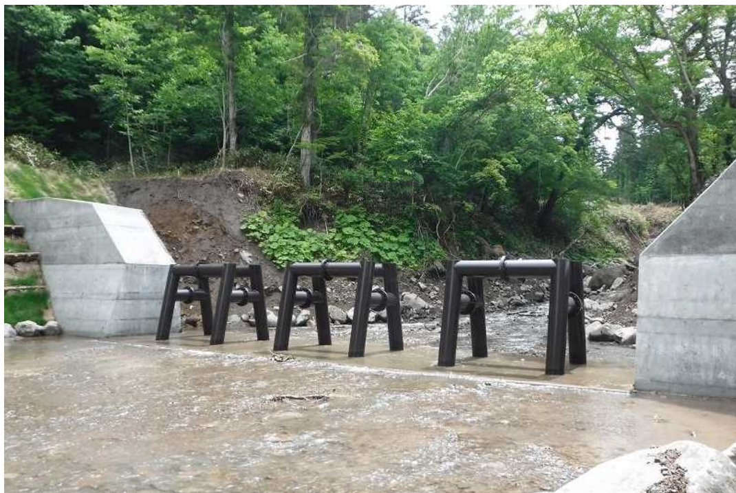
コンクリート谷止工
