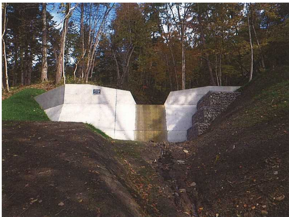
コンクリート床固工
