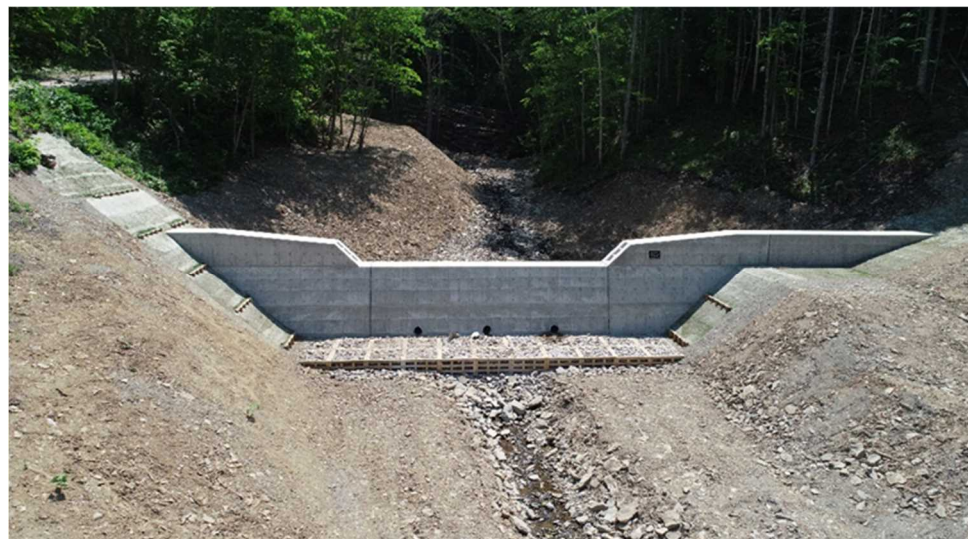
第7号コンクリート谷止工
