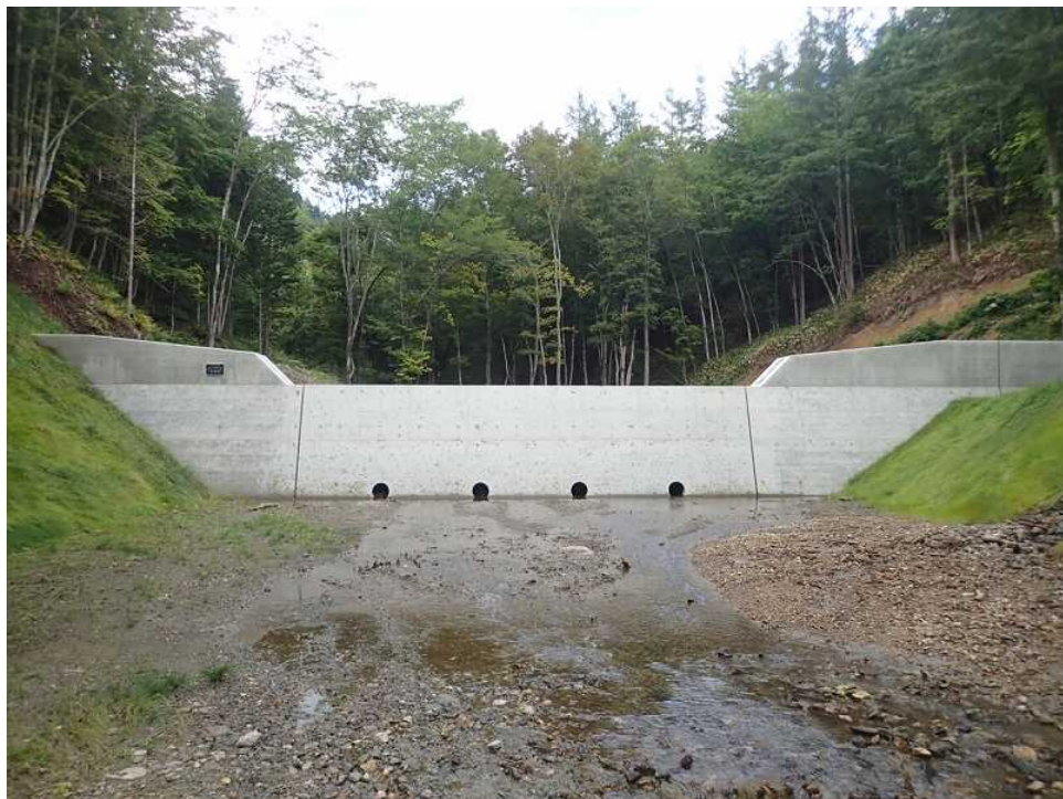
コンクリート谷止工
