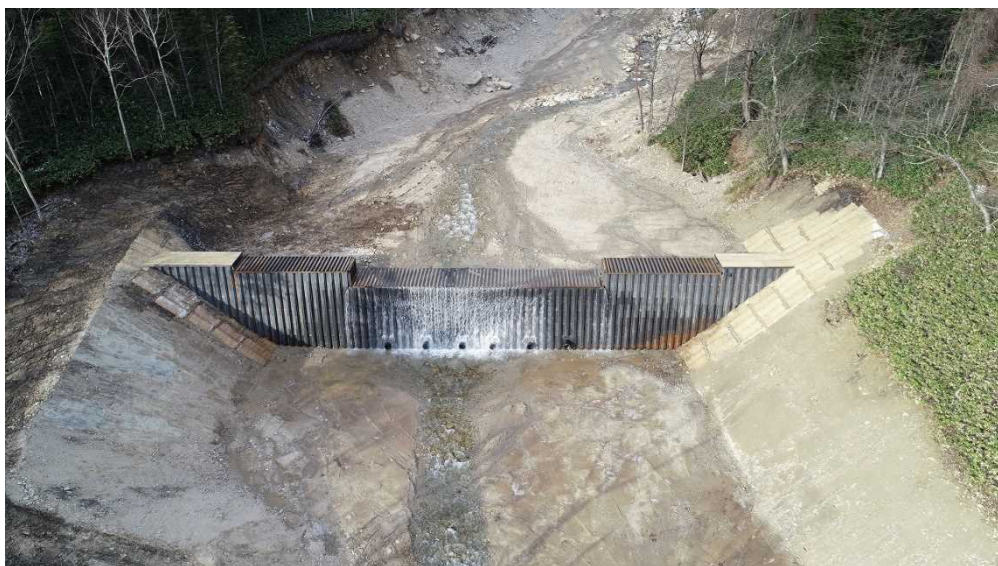
軽量鋼矢板床固工
