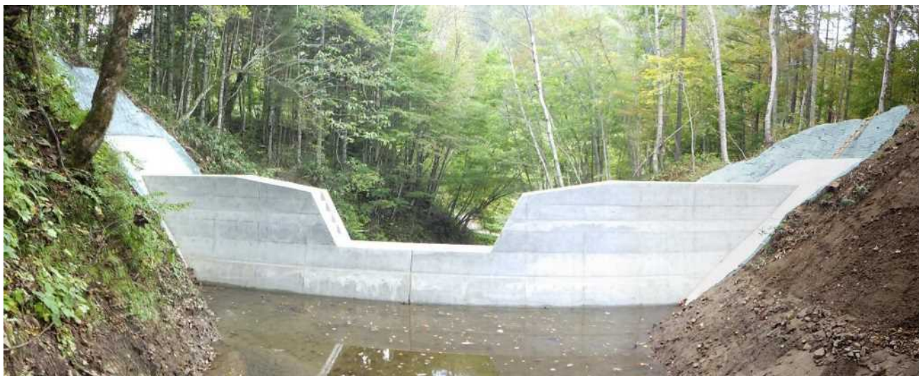
コンクリート床固工
