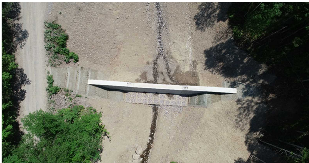
第6号コンクリート谷止工
