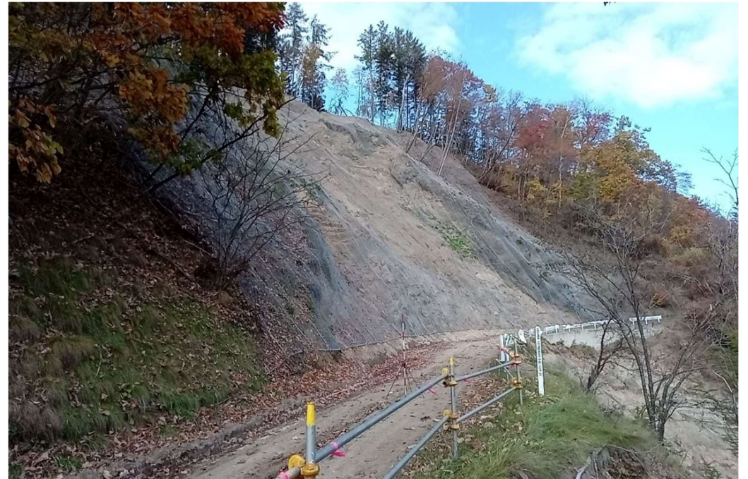
落石防止網工
