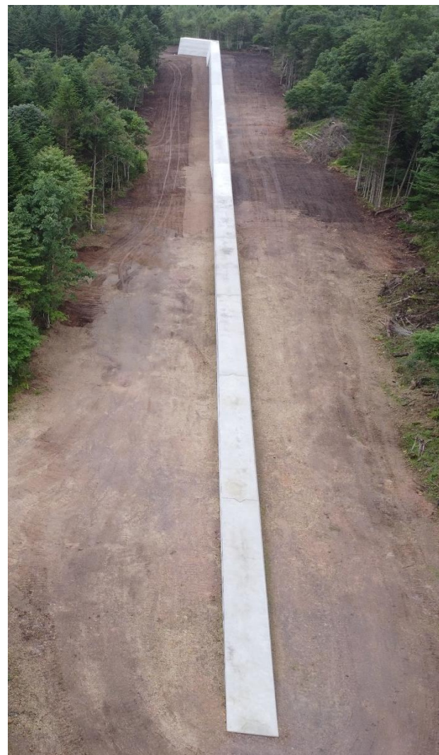
コンクリート導流堤（右岸）
