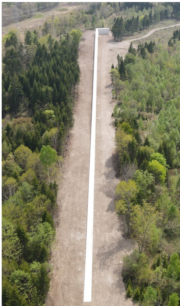
コンクリート導流堤（左岸）
