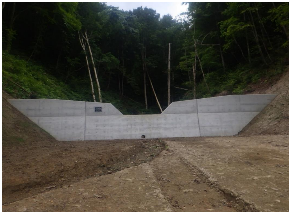
コンクリート谷止工
