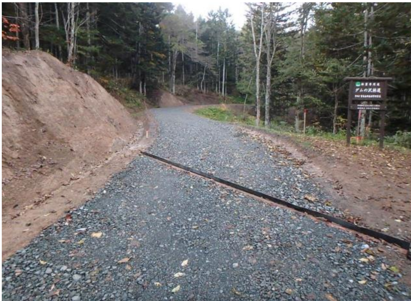
留萌北部森林管理署 ダムの沢林道（林業専用道）新設工事
