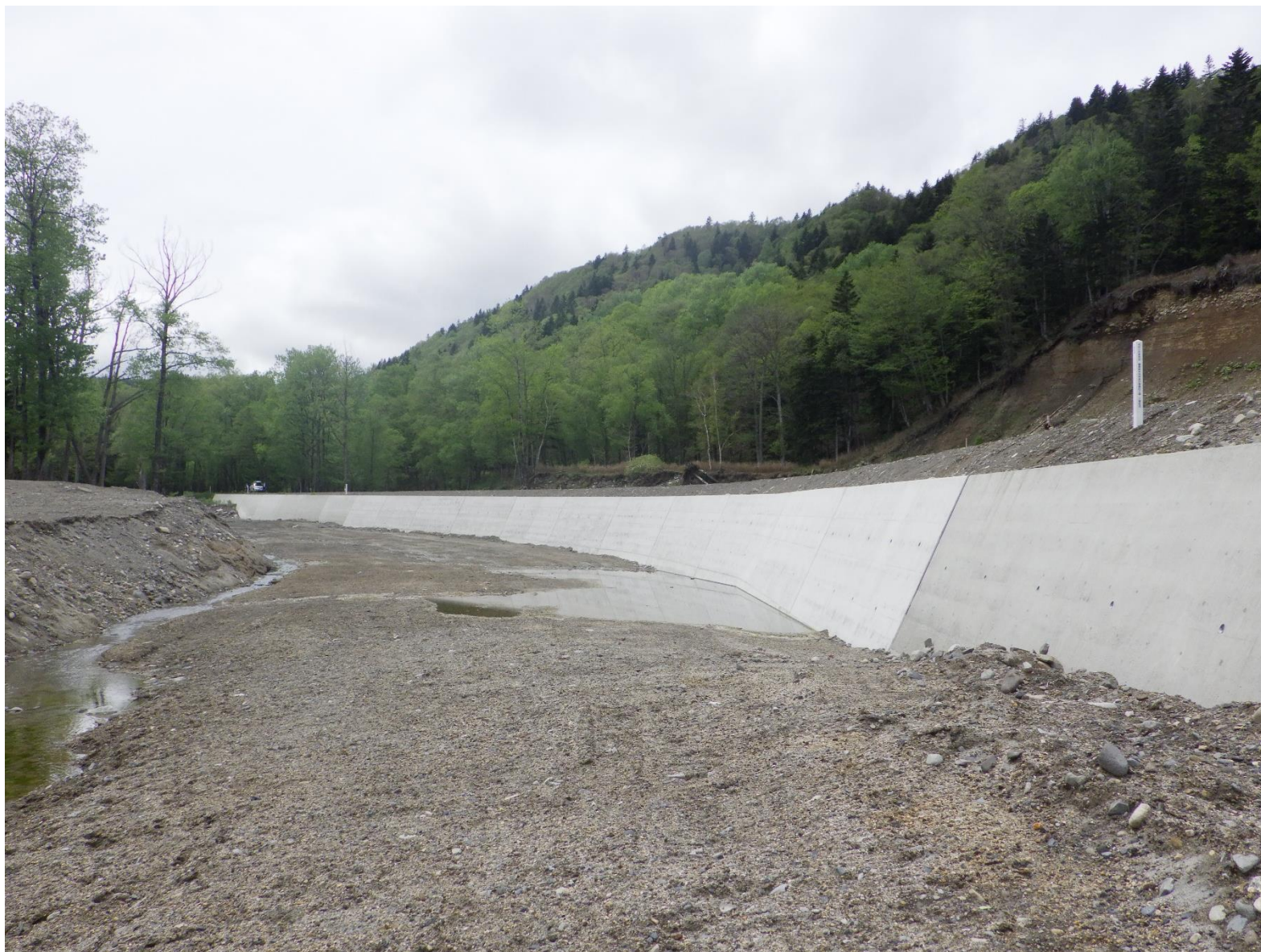
上川中部森林管理署 層雲峡本流林道災害復旧工事
