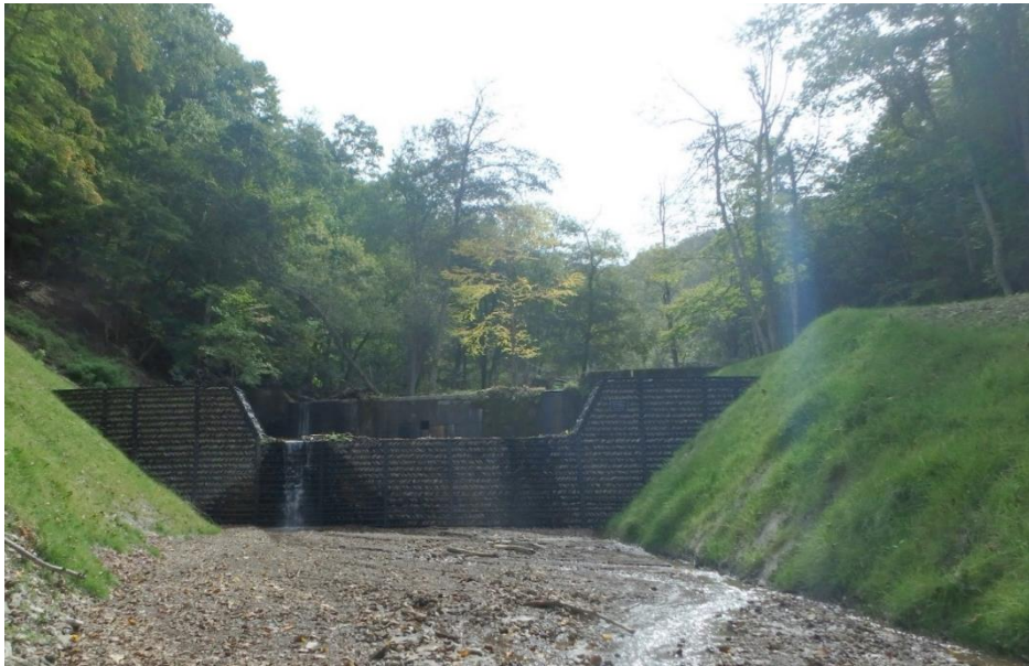
鋼製谷止工（6号）
