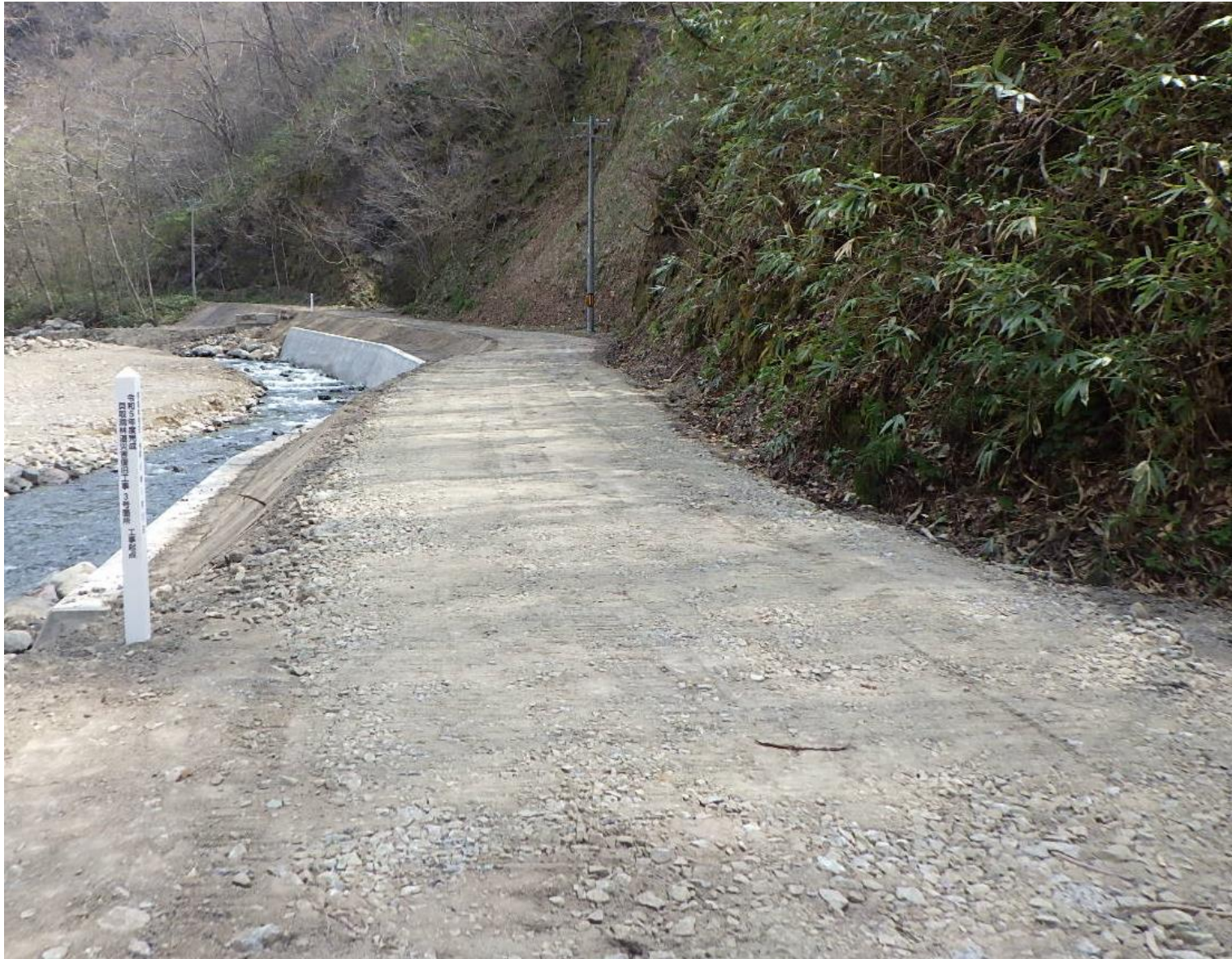
渡島森林管理署 貝取澗林道災害復旧工事
