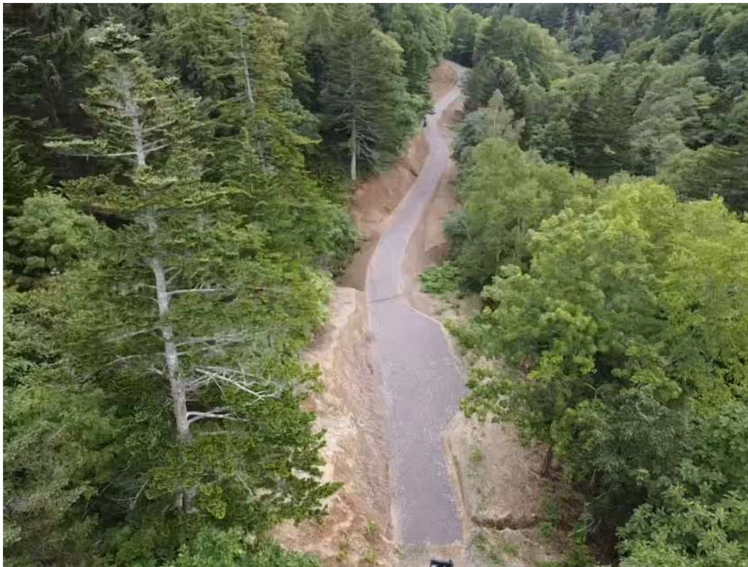
宗谷森林管理署 照陽支線林道（林業専用道）外新設及び改良工事
