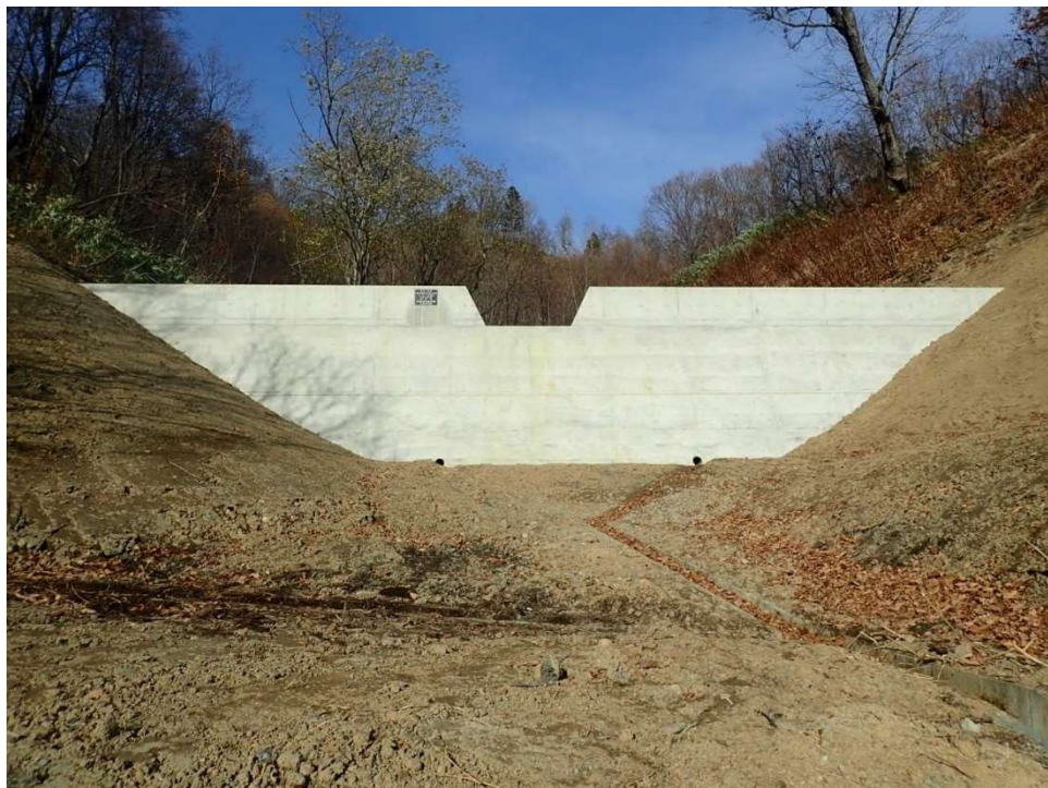
コンクリート床固工
