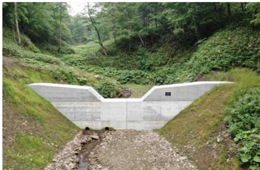
コンクリート谷止工
