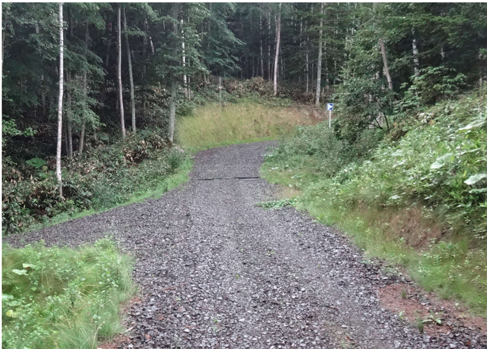
網走中部森林管理署 尚和2の沢林道(林業専用道)新設工事
