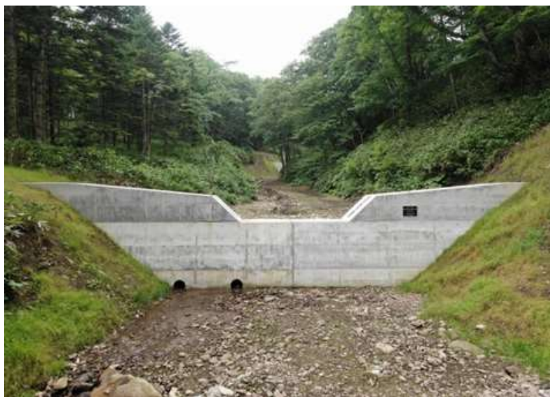
コンクリート床固工
