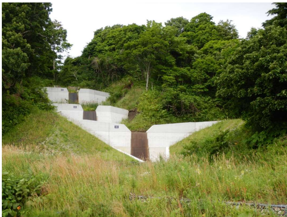
コンクリート谷止工
