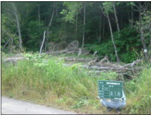
施工前の状況
