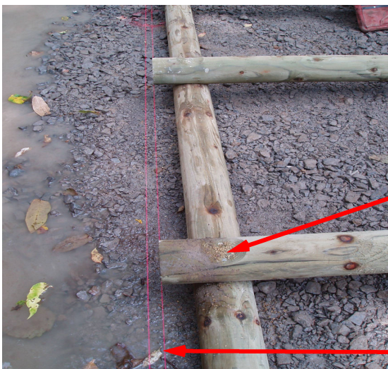
③ 最下段木材位置について、水系で通りを確認する。
