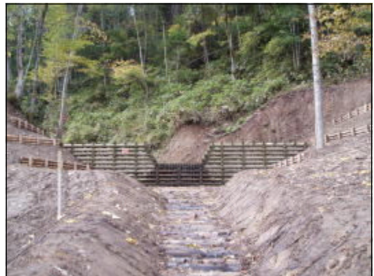
木製校倉敷床固工完成写真
