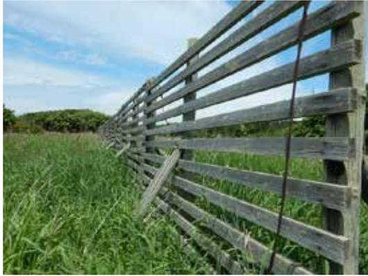
写真5-1(1) #112 堆雪柵(H20 設置)の状況
