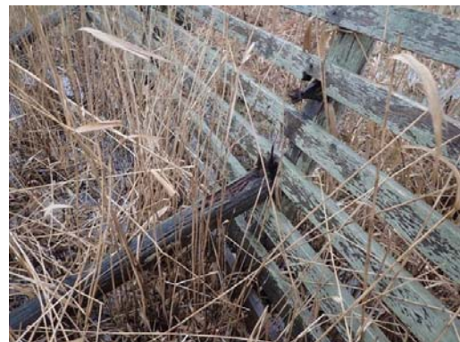
支え支柱の腐れと傾斜による支柱の抜け
