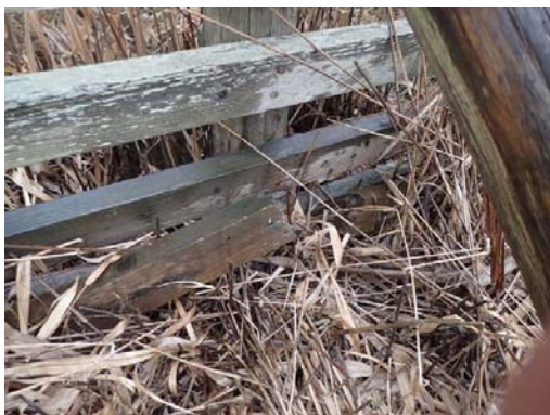
最下段の横板の破損
