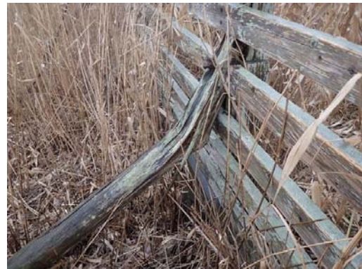
支え支柱の腐れ
