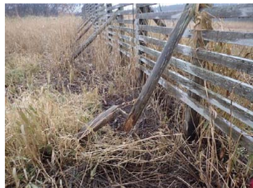
支え支柱の腐れ
