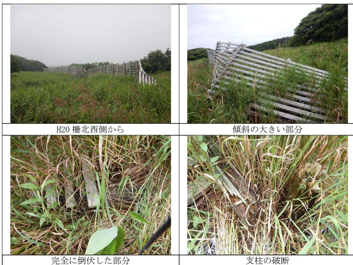
写真 5. 1-2 破損部分の状況
