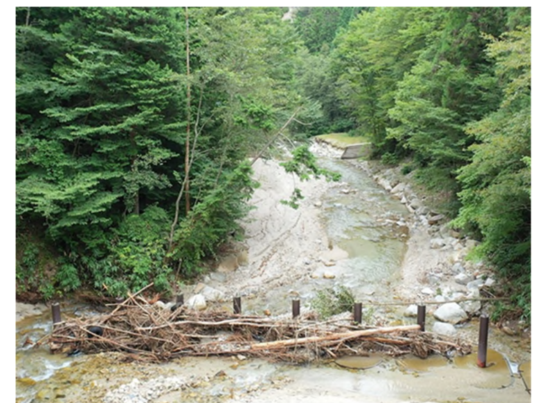
写真 3. 3. 独立基礎型流木捕捉工による流木捕捉事例 （中部森林管理局管内）
