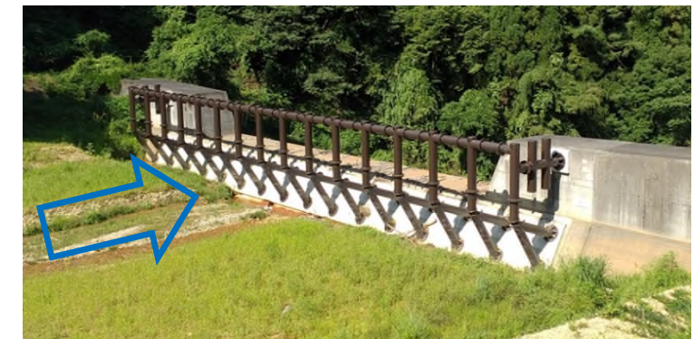
写真 3. 2. 既設ダムを利用した張り出し型流木捕捉工の施工事例 （長野県須坂建設事務所管内）
