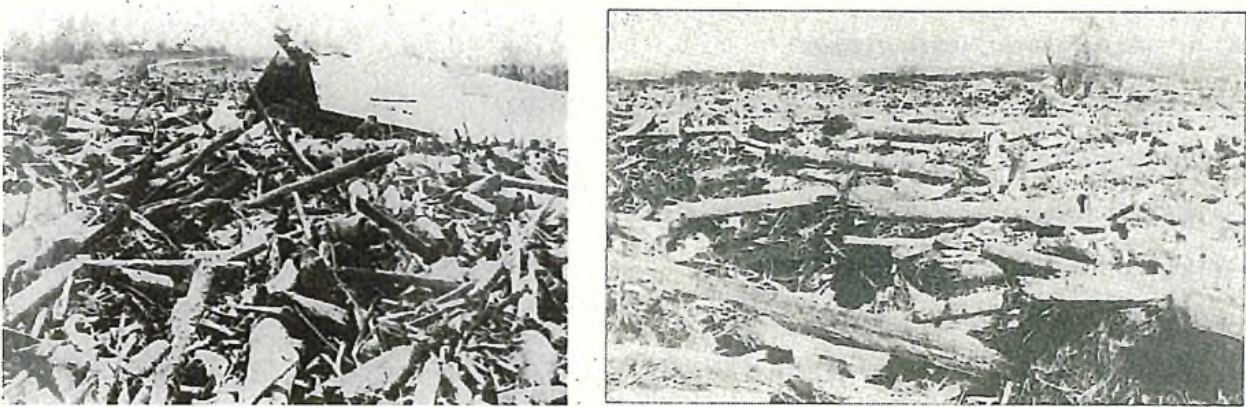
写真 3.1. 大正 15 年十勝岳噴火に伴う泥流により流下した流木等による被害状況 引用：大正 15 年十勝岳大爆発記録写真集 上富良野町郷土史館 ※当写真は上富良野町における被害状況であり、白金温泉での写真ではない。
