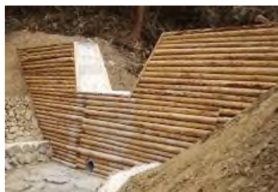
写真 6.3.4. 木製残存型枠
