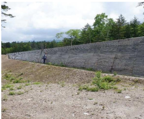
2号遊砂地 6号導流堤(施工中)
