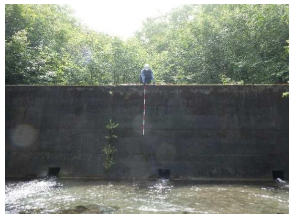
硫黄沢下流 ⑤ コンクリート堰堤 未満砂高:2.9m
