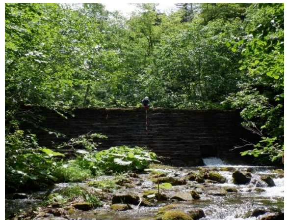
硫黄沢右支流 75 第2号コンクリート堰堤 未満砂高:3.0m
