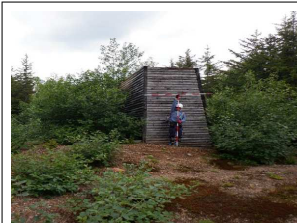
硫黄沢上流 118 第7号コンクリート導流堤
