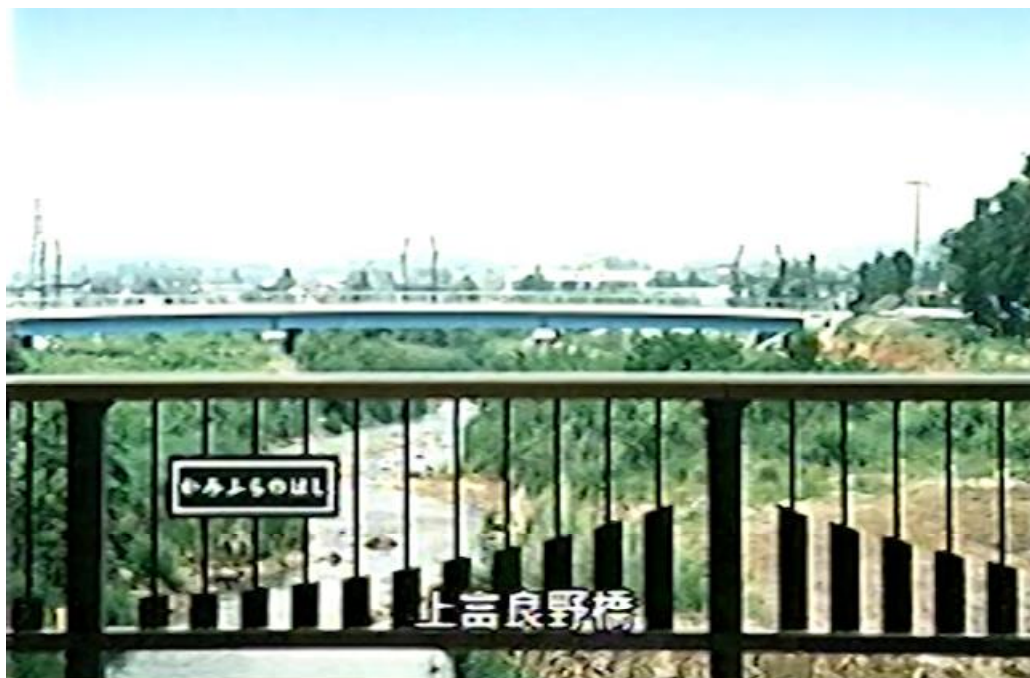
泥流発生前の上富良野橋
