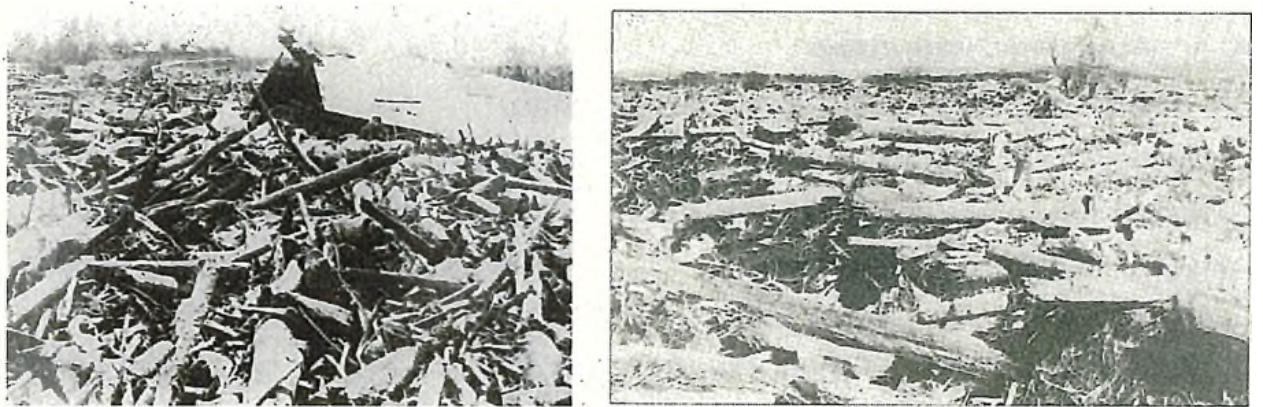
写真 3.3.1. 大正 15 年十勝岳噴火に伴う泥流により流下した流木等による被害状況 23) ※当写真は上富良野町における被害状況であり、白金温泉での写真ではない。
