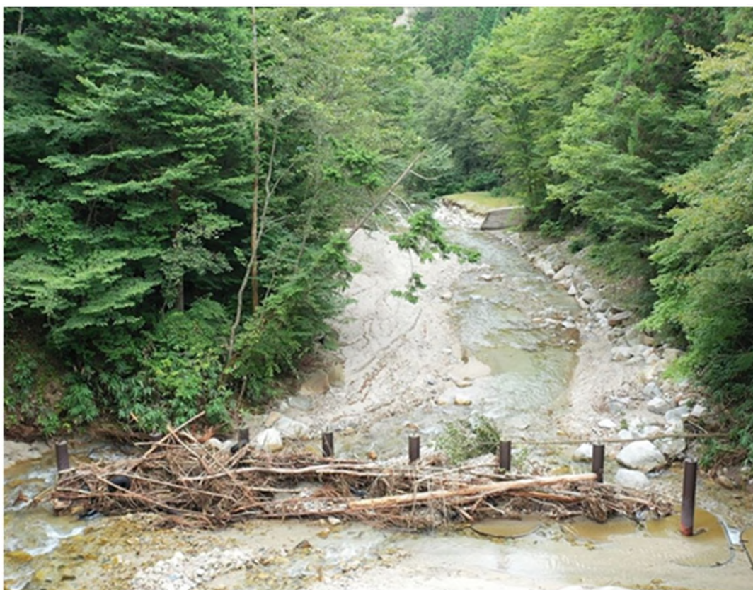
参考：写真 6. 3. 2. 独立基礎型流木捕捉工による流木捕捉事例 (中部森林管理局管内)
