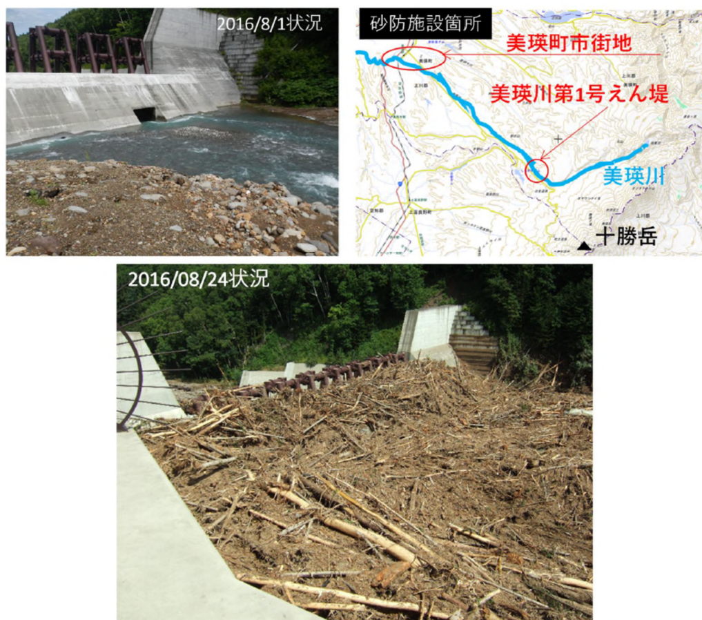
図 2-12 平成 28 年 8 月の豪雨時に発生した流木の捕捉状況（美瑛川第 1 号えん堤）
