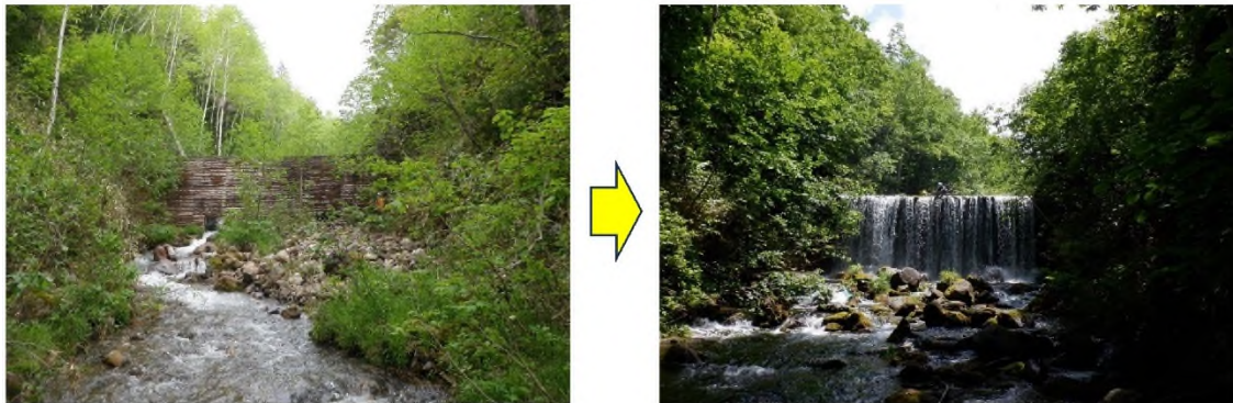
写真 4. 1. 溪流付近：施設番号 67（H7 年施工）の経年変化 左：2012/6/10 撮影，右 2022/6/21 撮影
