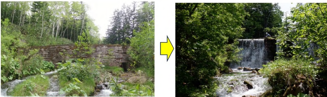
写真 4. 2. 溪流付近：施設番号 65（H6 年施工）の経年変化 左：2012/6/10 撮影，右 2022/6/21 撮影
