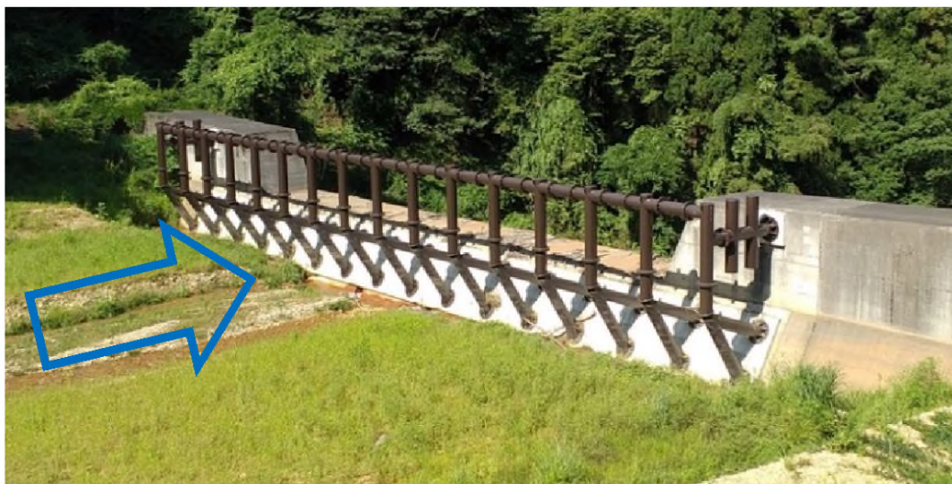
参考：写真 6. 3. 1. 既設ダムを利用した張り出し型流木捕捉工の施工事例 (長野県須坂建設事務所管内)
