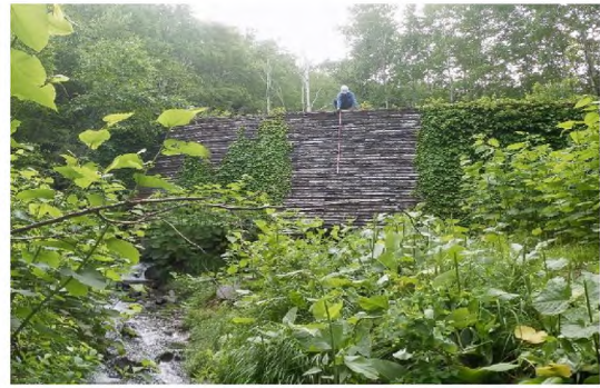
写真 4. 3. 溪流付近：施設番号 74（H7 年施工）の経年変化
