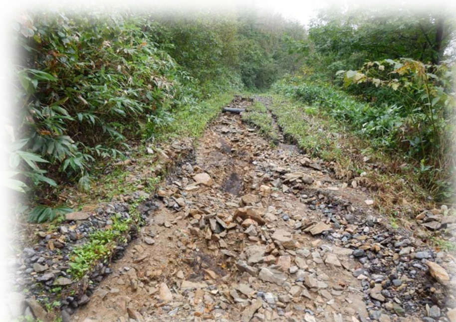
作業道修理(路面整正・敷砂利)
