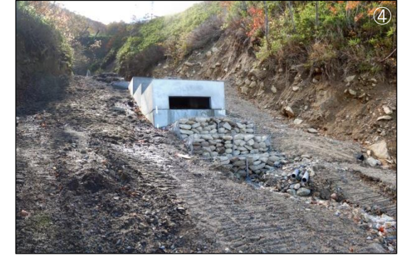
【保全対象（開発局・清水町取水施設）】
