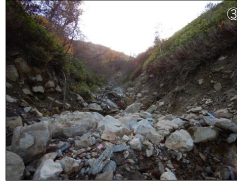
【上流荒廃状況】
