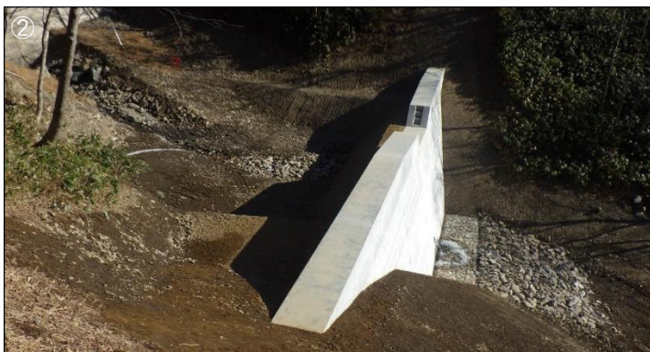
【完成写真(側面)】
