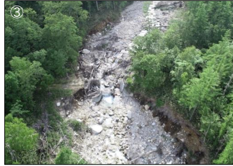
【工事箇所周辺の被災状況】
