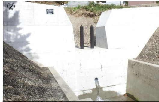
【1号コンクリート谷止工】
