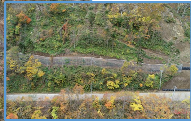
落石防護柵工完成
