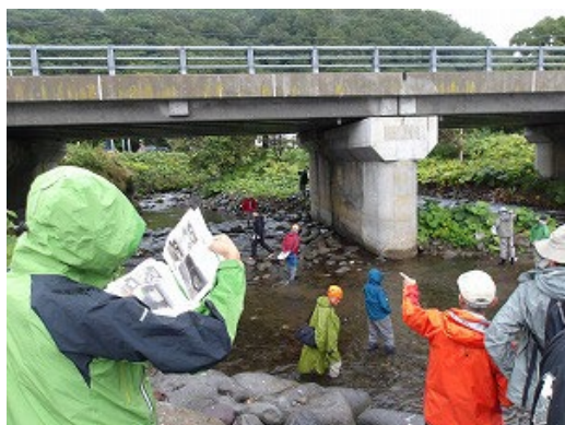
朔北橋保全工事の確認
