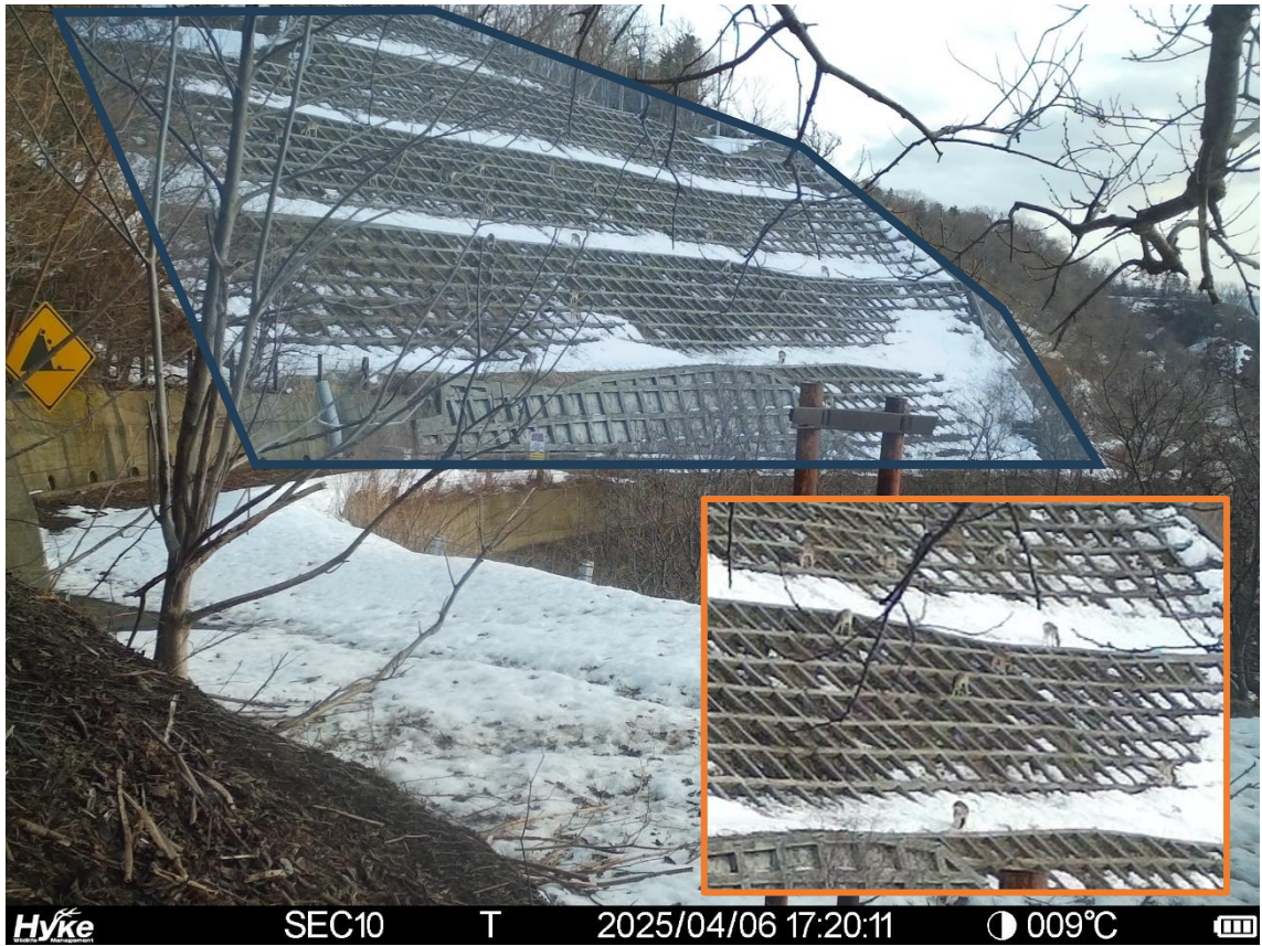
図 6. 自動撮影カメラ「滝見橋左岸」の画角、青枠で示した範囲が「滝見橋左岸法面」として取り扱いを分けた範囲に該当する。橙枠は「法面」の一部を拡大した画像
