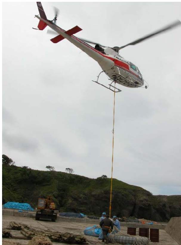
写真1 2 文吉湾資材吊り上げ作業
