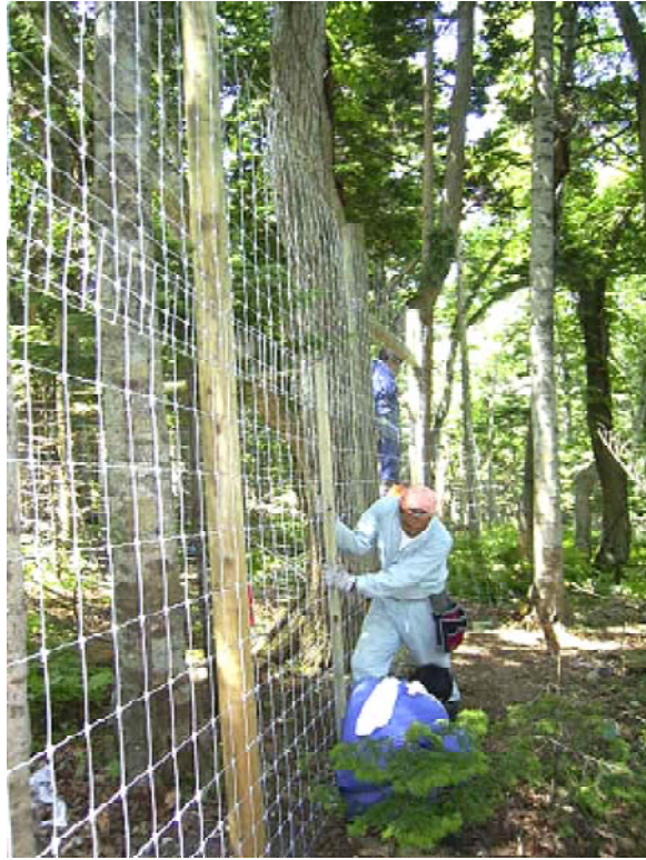
写真19 支柱によるフェンス固定作業
