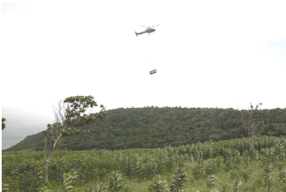
写真 1 4 資材運搬状況
