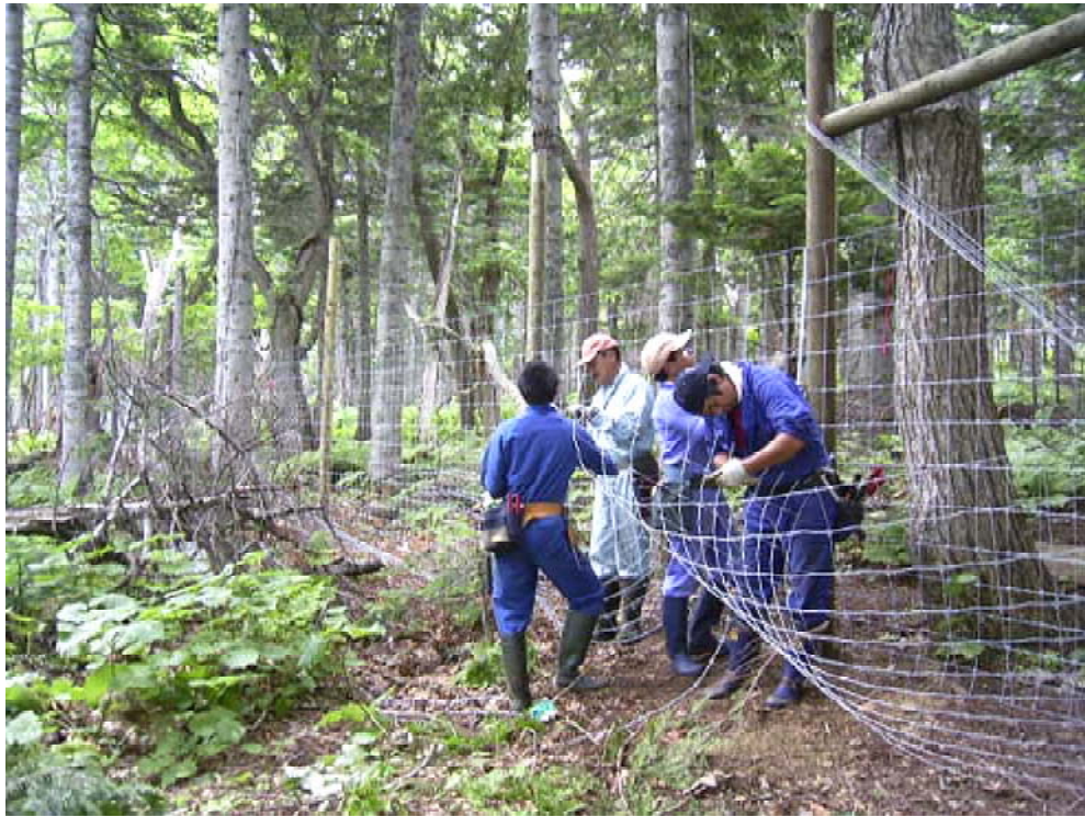
写真17 フェンス金網の取付作業
