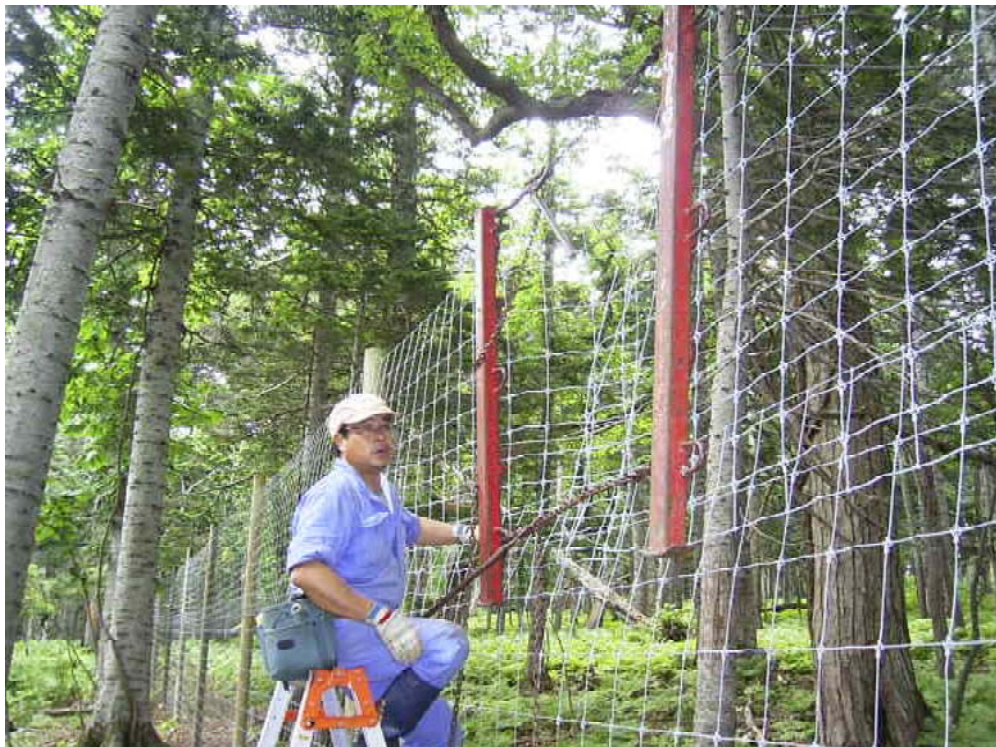
写真18 フェンス緊張作業
