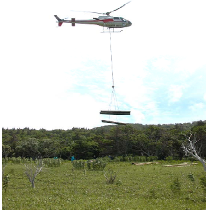
写真 1 5 林内入口への資材運搬
