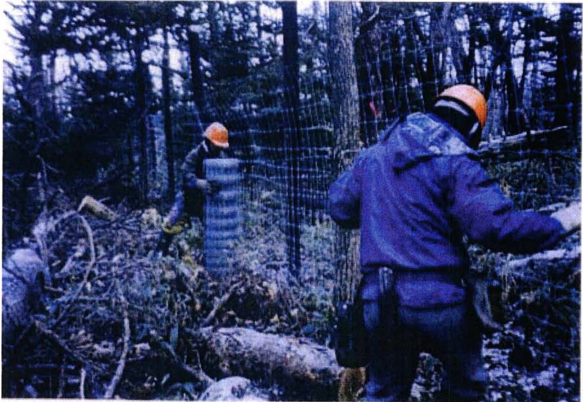
写真 12 フェンス仮張り付け
