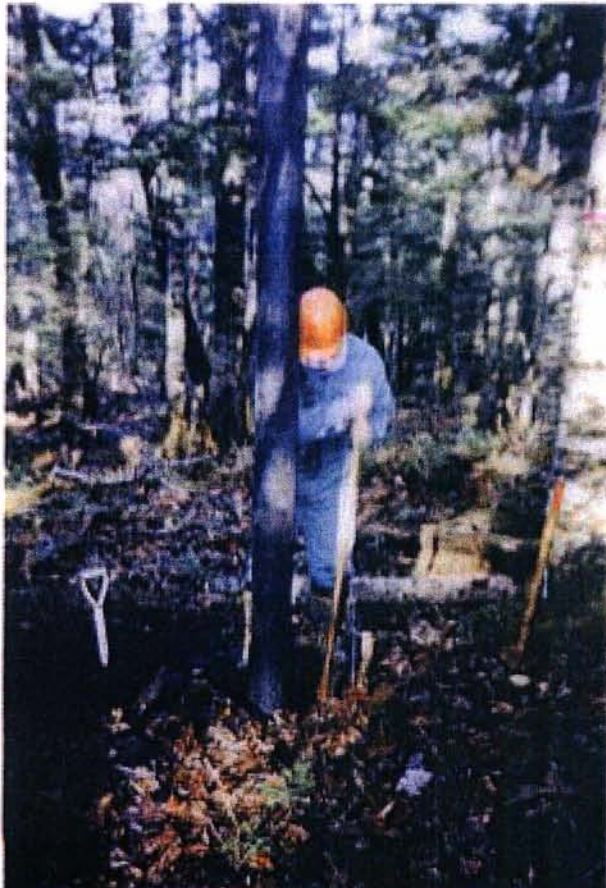
写真9 木柱穴の掘削
