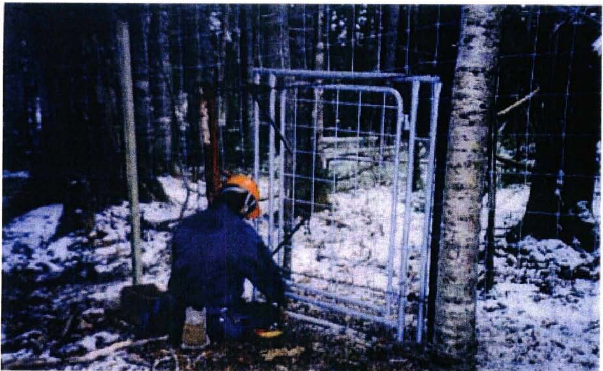
写真 15 中間杭の取り付け
