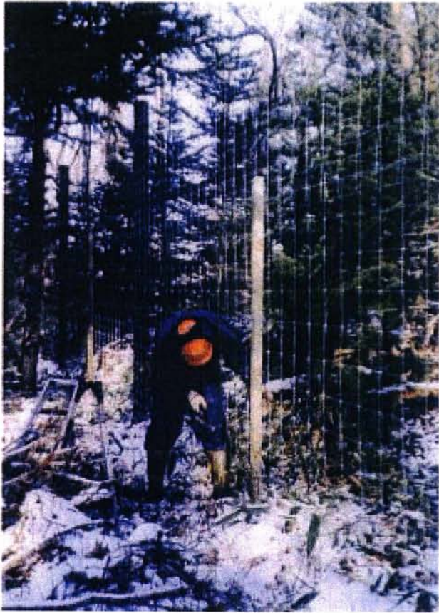
写真 15 中間杭の取り付け
