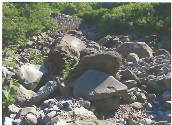
上流の土砂堆砂状況。
