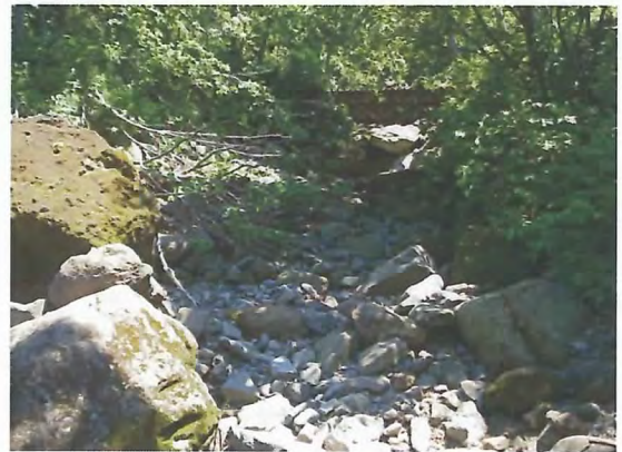
上流の土砂堆砂状況。
