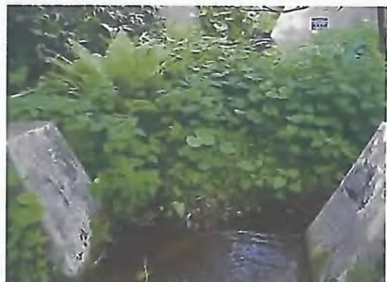
上流の土砂堆砂状況。
