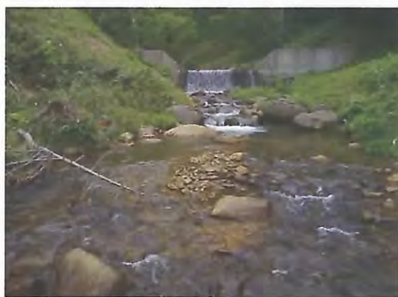
上流の土砂堆砂状況。
