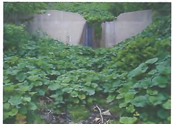
上流の土砂堆砂状況。
