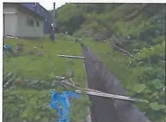
水路工の状況。V型トラフ600mm使用。
