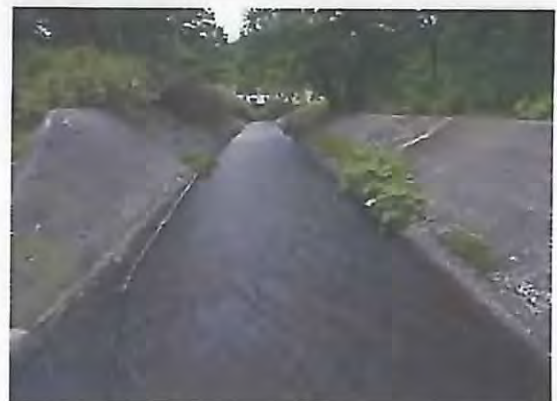
三面張水路工内の状況。
