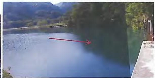
上流の土砂堆積状況。
