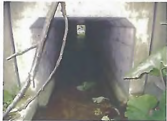
ボックスカルバート内の状況。
