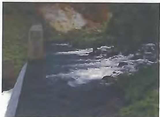
上流の土砂堆砂状況。
