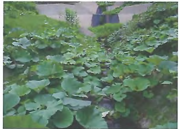
上流のブールロック三面張り水路工の状況。
