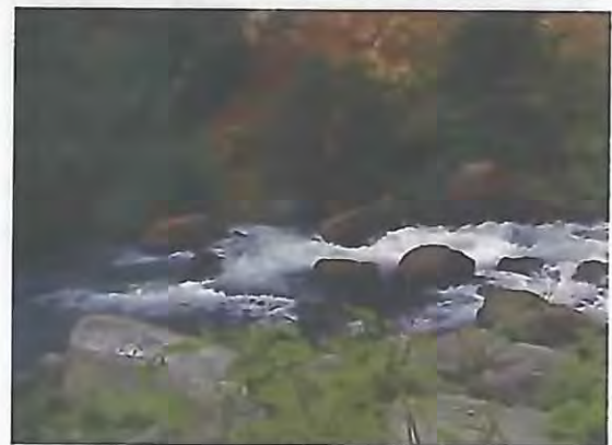
上流の土砂堆砂状況。
