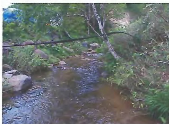
上流の土砂堆砂状況。
