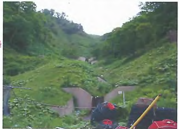
落差工の全体配置状況。
