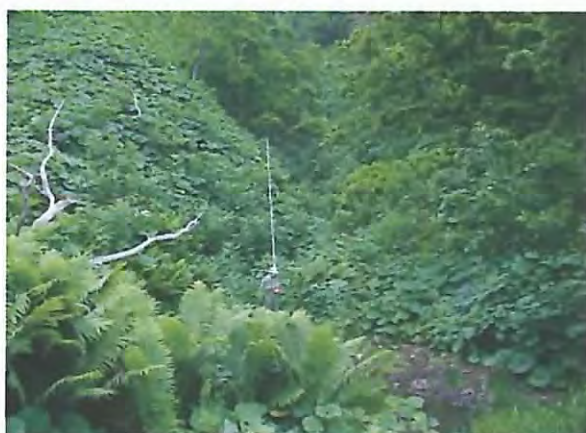
上流の土砂堆砂状況。
