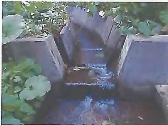
水路工起点の落差工(落差0.25m)。
