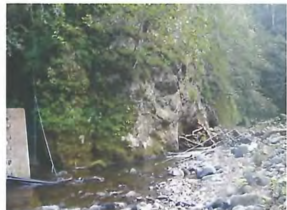
上流の土砂堆積状況。
