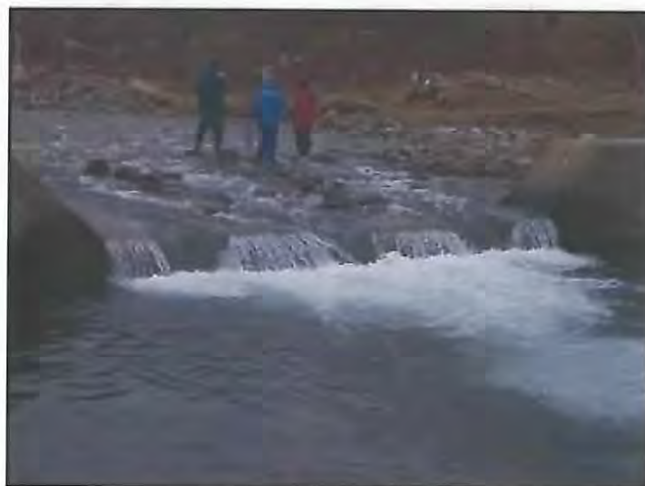
No. 2 床固工（ルシャ川）
