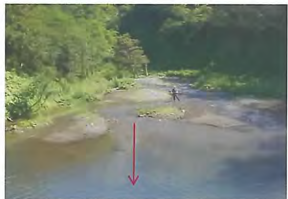
上流の土砂堆積状況。
