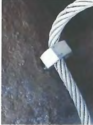
ジョイントロック・ボルト埋め込み写真
