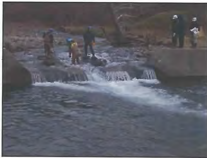
No. 1 床固工（ルシャ川）
