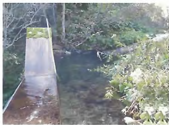
上流の土砂堆砂状況。
