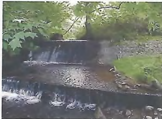
下流より望む。落差が2段式となっている。
