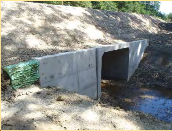
林道改良工事
