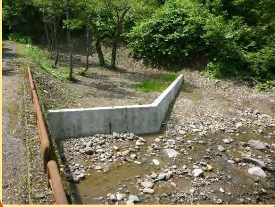
林道改良工事
