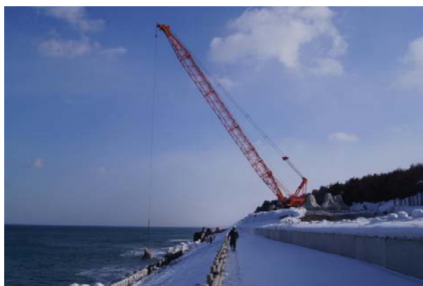
○大型クレーンによる防潮護岸工事
