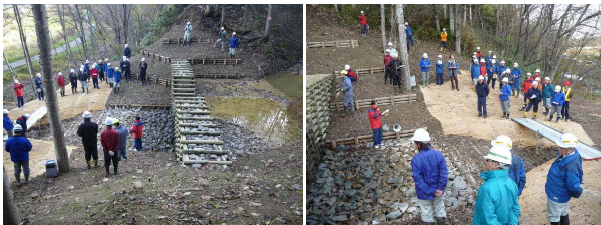
間伐材を利用した治山ダム見学会（平成23年10月28日）
