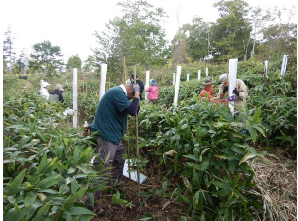
▽植栽木に保護管を設置する様子
