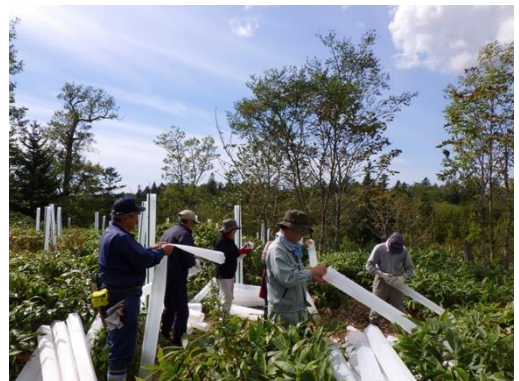
△保護管を組立てる様子
