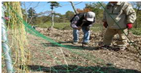
杭でスカートネットを固定
