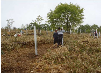
▽ツリーシェルター設置の様子
