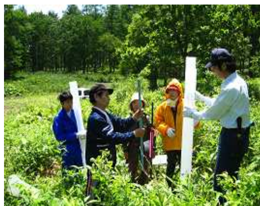
写真5 ヘキサチューブの取付け
