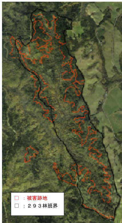
図8 293林班と被害跡地 H16.10撮影(環境省)
