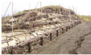
写真4 粗朶柵設置状況
