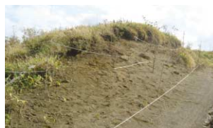
写真3 設置前の状況
