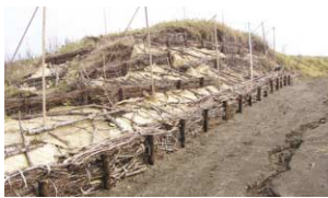
写真4 粗朶柵設置状況
