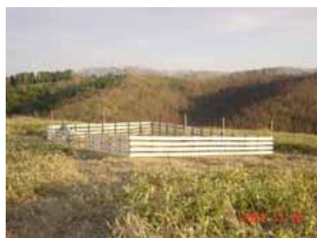
図7 防風柵の設置状況
