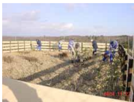
図8 防風柵内での植栽
