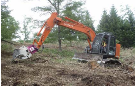
大型機械による地表処理
