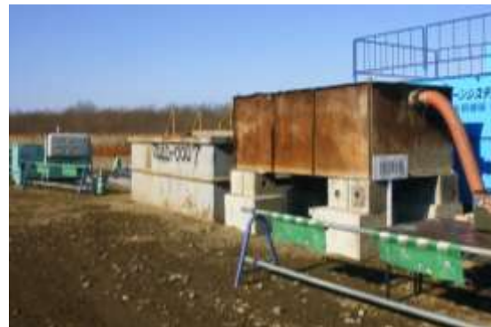
図 3-11 (例) 濁水流出・拡散の抑制 (左)、沈殿池による濁水処理 (右)
