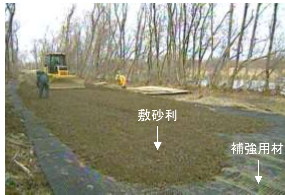
図 3-10 (例) 現況地盤圧密の軽減対策
