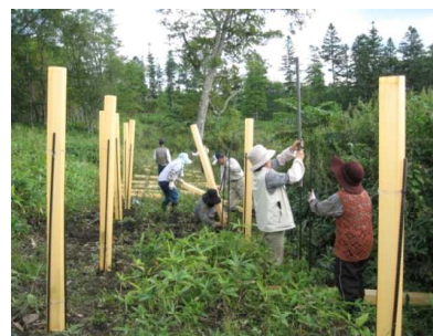
写9 ヘキサチューブ設置の様子
