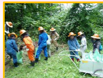
作業道敷き砂利作業
