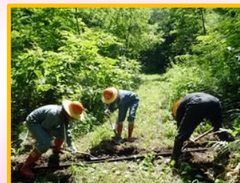
作業道の水切り作業
