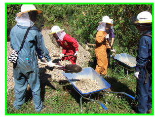
道路補修（敷砂利）作業
