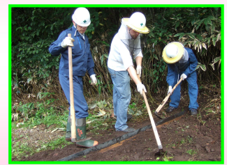
道路補修（横断排水溝設置）作業
