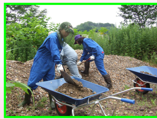
道路補修（敷砂利）作業
