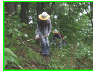
歩道修理作業
